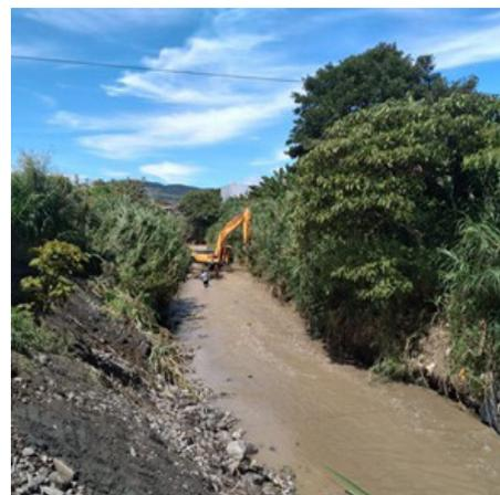
Por medio de estas atenciones, se evitó el desbordamiento de ríos y quebradas, dándole protección a la infraestructura vial y asimismo la protección de viviendas. Se atacó de manera preventiva evitando la acumulación de materiales que provoquen el desbordamiento de estos y disminuyendo el impacto en épocas de lluvias.
