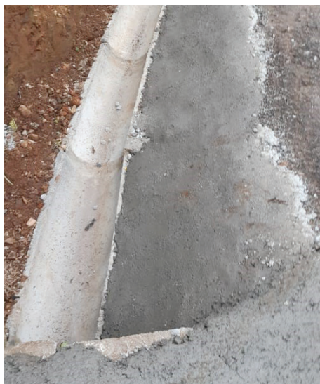
Mejoramiento Sistemas Pluviales de Caragral.
