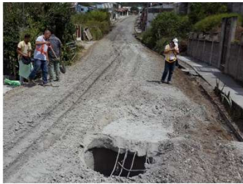
Camino antes de la intervención
