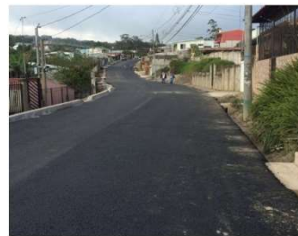
Camino después de la intervención
